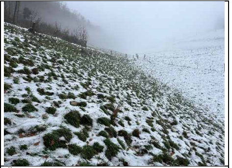
Östlicher Perimeter Gefahrenquelle, Blickrichtung E
