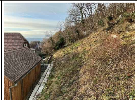
Mittlerer Perimeter der Gefahrenquelle, bei SO-2015-R-00009, mit Stützmauer, Blickrichtung W
